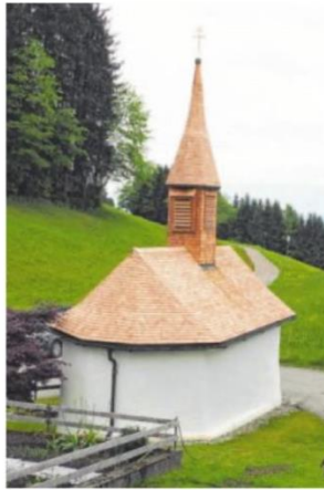
Die mehr als 3500 Dachschindeln wurden erneuert.
